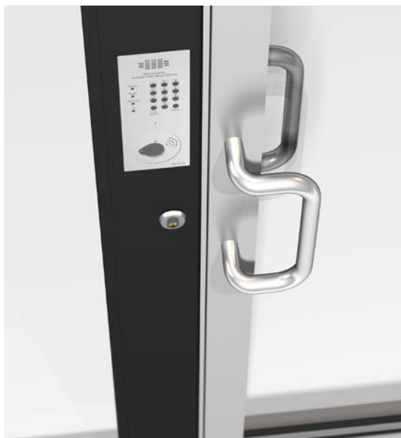
Entré med porttelefon/passersystem. Dörr naturanodiserad och karmar pulverlackerade. Lås monterat i karm. Förstärkt anslagsprofil.
